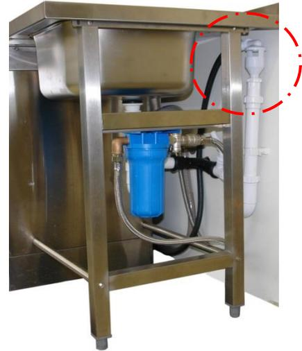
Der Freie Auslauf für die Konzentratleitung muss immer angeschlossen werden. Nur dadurch wird das Osmosemodul sicher von der Abwasserleitung getrennt.
